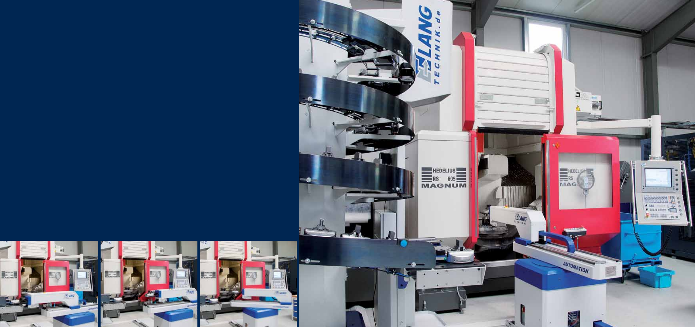
Die HEDELIUS RS 605 wurde mit moderner Automations- technik von Lang ausgerüstet. Das Beladen mit Werkstück- paletten läuft vollautomatisch.
